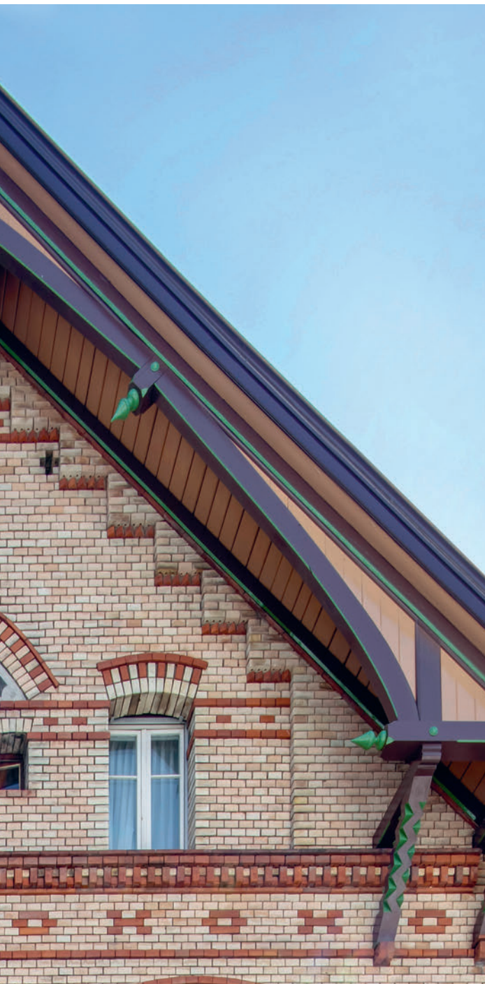
Westfassade mit dem wiederentdeckten Sgraffito mit Pferdekopf sowie den sorgfältig instand gestellten Zierelementen. Bild: sqwer, 2018.
