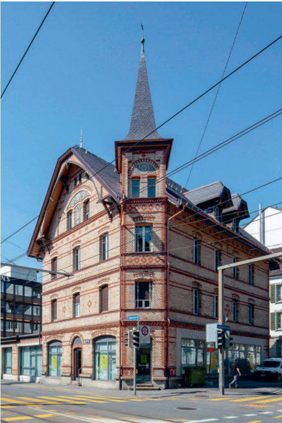
Das Gebäude Belpstrasse 24 in seiner exponierten Lage an der Kreuzung Schwarztorstrasse / Belpstrasse. Bild: sqwer, 2018.
